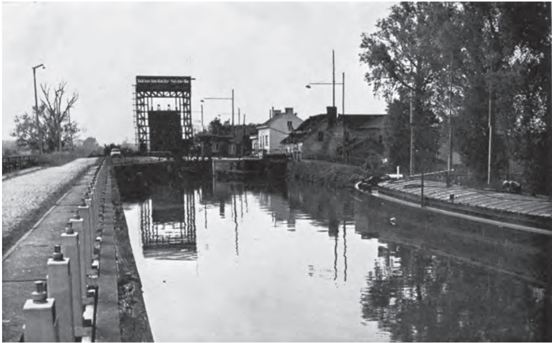
L'écluse de Malmaison et sa porte levante aval en position relevée mettant en communication le sas avec le bief aval, vers 1960. Collection A. Auquier.
