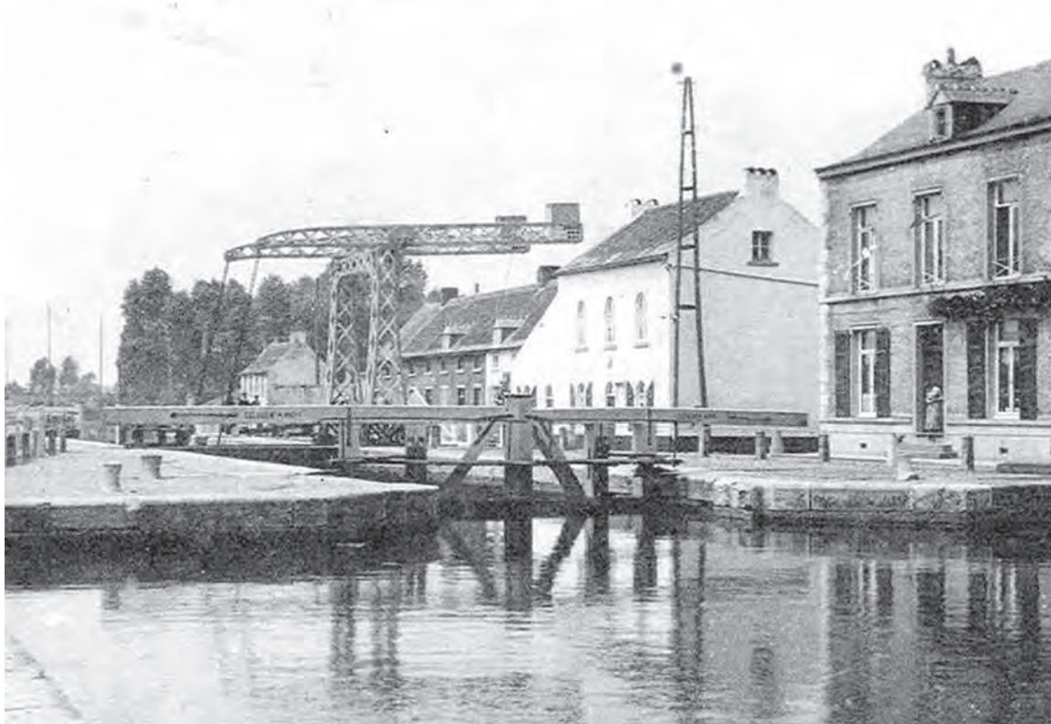
Écluse de Boussu-Herbières : les poutrelles de manœuvre des portes busquées débordent largement de part et d'autre du sas, début du XX e siècle. Collection M. Capouillez.
