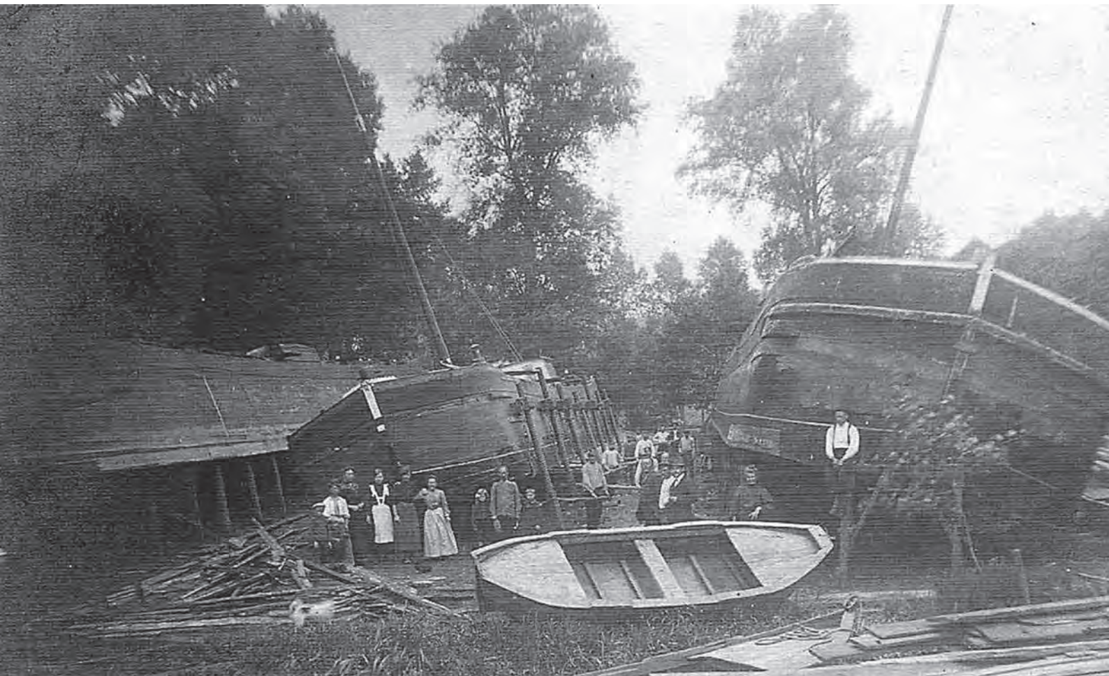
Bateaux en cale sèche au chantier Dangreau, à Boussu-Herbières, vers 1930. On procède au soulèvement manuel de celui de gauche à l'aide de crics à vis. Collection privée.
