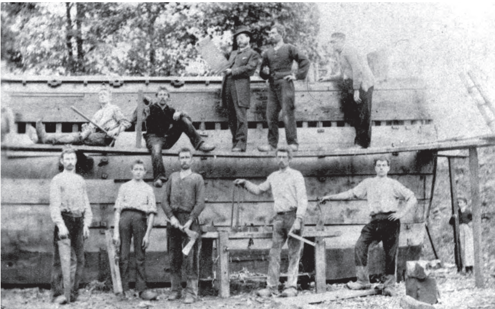
Chantier de construction de bateaux à Saint-Ghislain, en 1887 (VIII.12). On notera les outils des ouvriers, de gauche à droite, en haut : le hoyau et la varlope (VIII.13); en bas, l'égoïne, la varlope, la hache, la scie à refendre, l'équerre et la demi-varlope. Collection privée.
