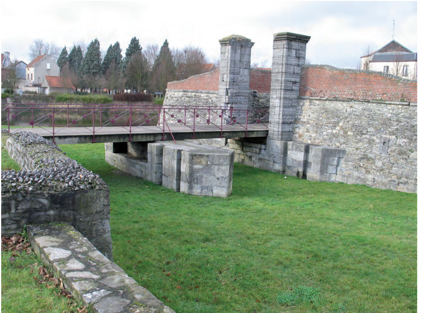
L'écluse de Gueulzin et la porte du Quesnoy à Condé. À l'arrière-plan, l'ancien lit de l'Escaut. 2005. Photo Y. Coutiez.
